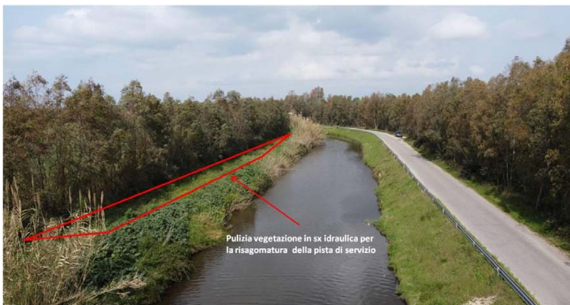
Figura 24 Pulizia della vegetazione necessaria alla risagomatura della pista di servizio per l'accesso al canale in sinistra idraulica
